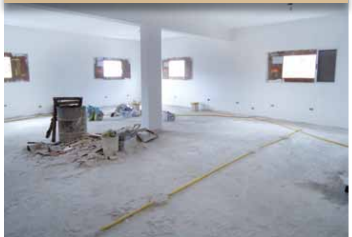
Amplas salas para conforto dos trabalhadores
